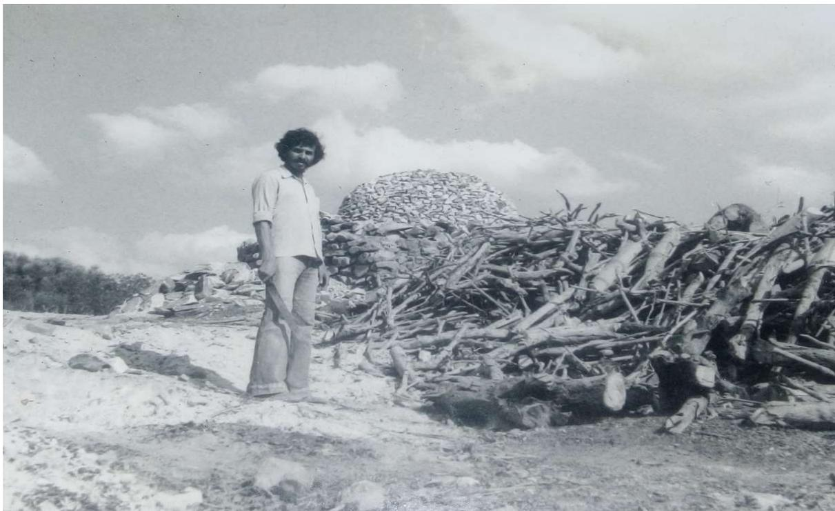
Fonte: Foto Josué Eusébio Ferreira, 1974. Local do forno de Manoel Cosmo (ver ponto 22, na figura 6, página 65). Destaca-se ao fundo a estrutura do forno com o capote pronto, no pátio externo, depositada a lenha que seria utilizada para queima – possivelmente da espécie avelós.
