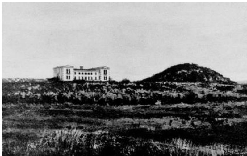
Imagem 16 - Vista à distância do prédio da Escola Superior de Agricultura, Em processo de construção. Fonte: Acervo do Mosteiro de São Bento, em Olinda - PE
