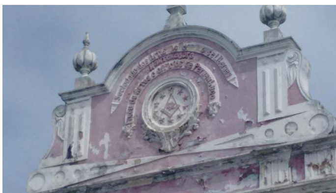
Figura 5 – Fachada do Liceu de Artes e Ofício do Recife com o símbolo maçônico do esquadro e do compasso 227
