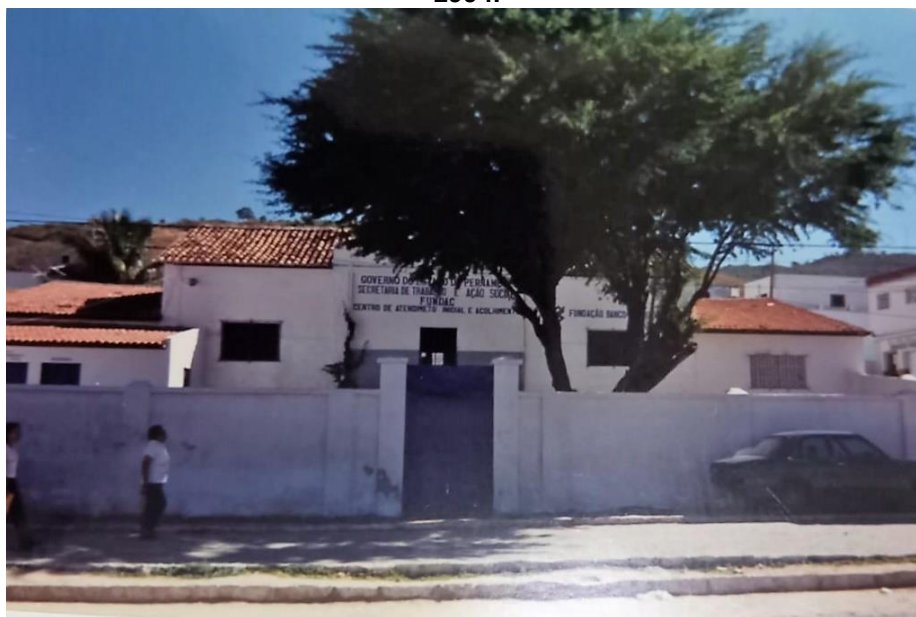
Imagem 6 – Calçada do Centro de Atendimento Inicial e Acolhimento – FUNDAC, dezembro de 1994.
