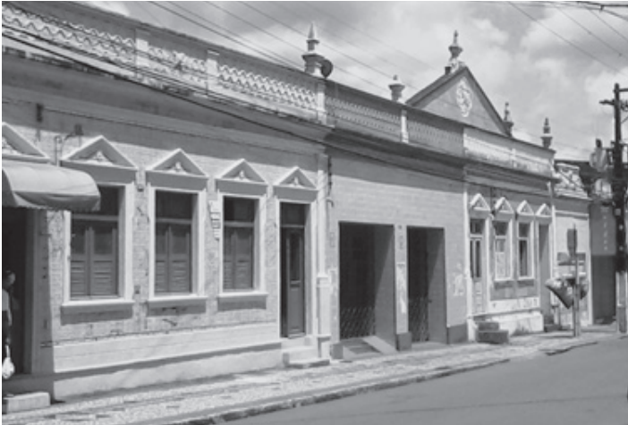
Figura 3: Bloco de edificações dos números 82, 90 e 100 da Rua Vigário J. Batista. Fonte: autor, 2018.
